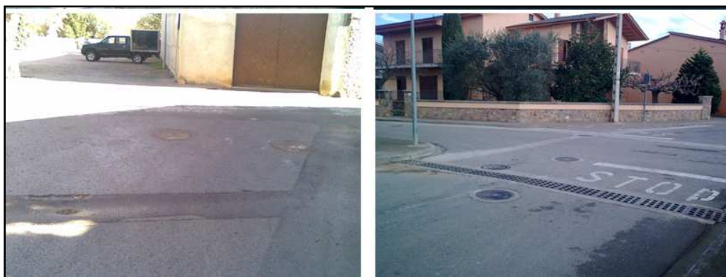
Les obres de sanejament es van realitzar durant el 2010
