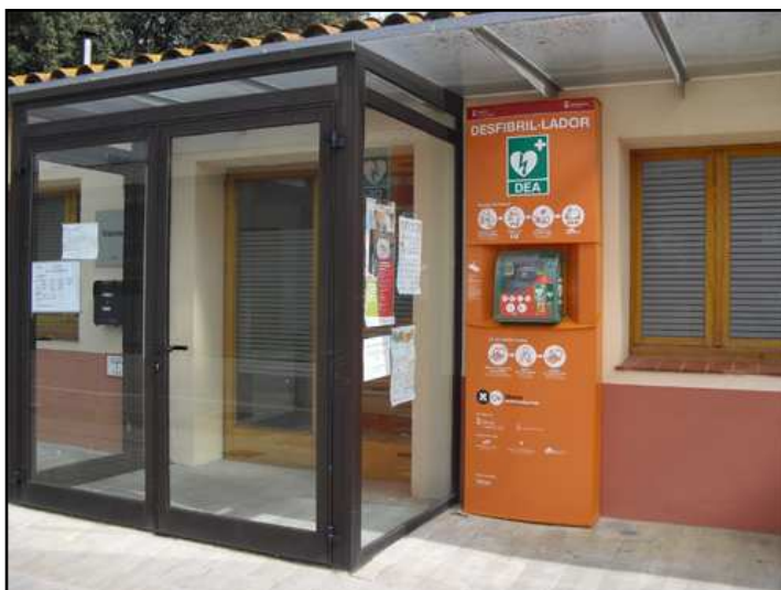
Els desfibril·ladors s'han instal·lat al costat del dispensari i a l'entrada de Torremirona
