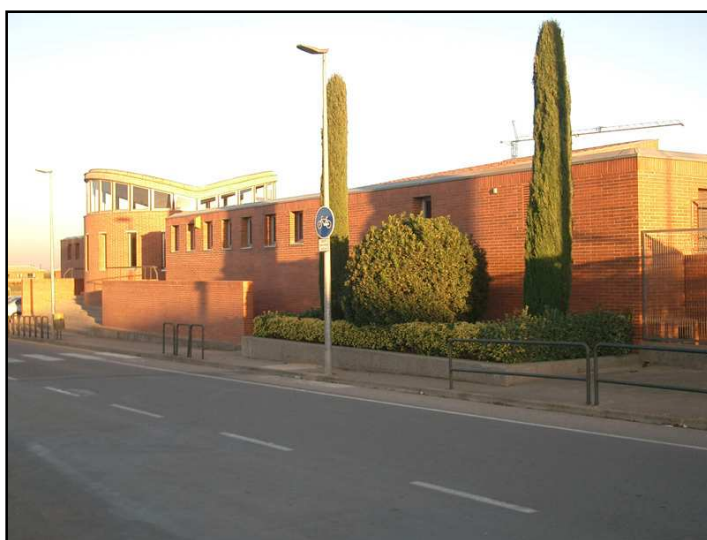
En l'actualitat ja s'han iniciat les obres d'ampliació del CEIP J. Vallmajó 2ª fase
